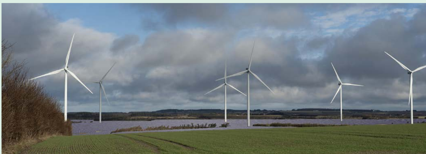
Området set fra Kanstrupve, lige efter opførel
